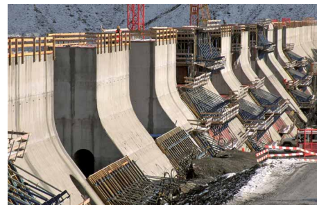
Staumauerbau Muttenalp (© Axpo)
