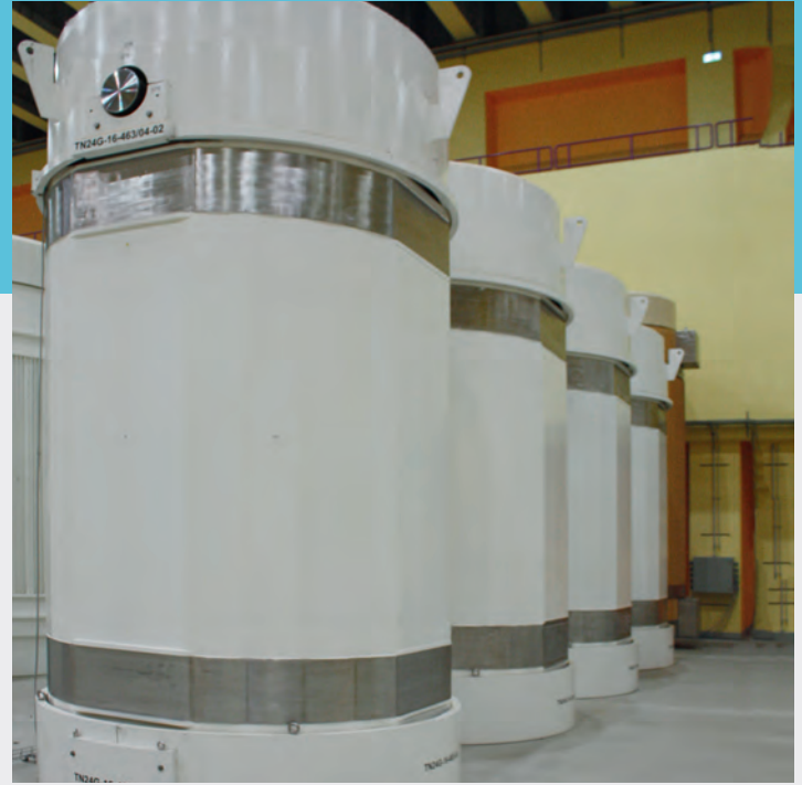
TRANSPORT- UND LAGERBEHÄLTER MIT ABGEBRANNTEN BRENNELEMENTEN
